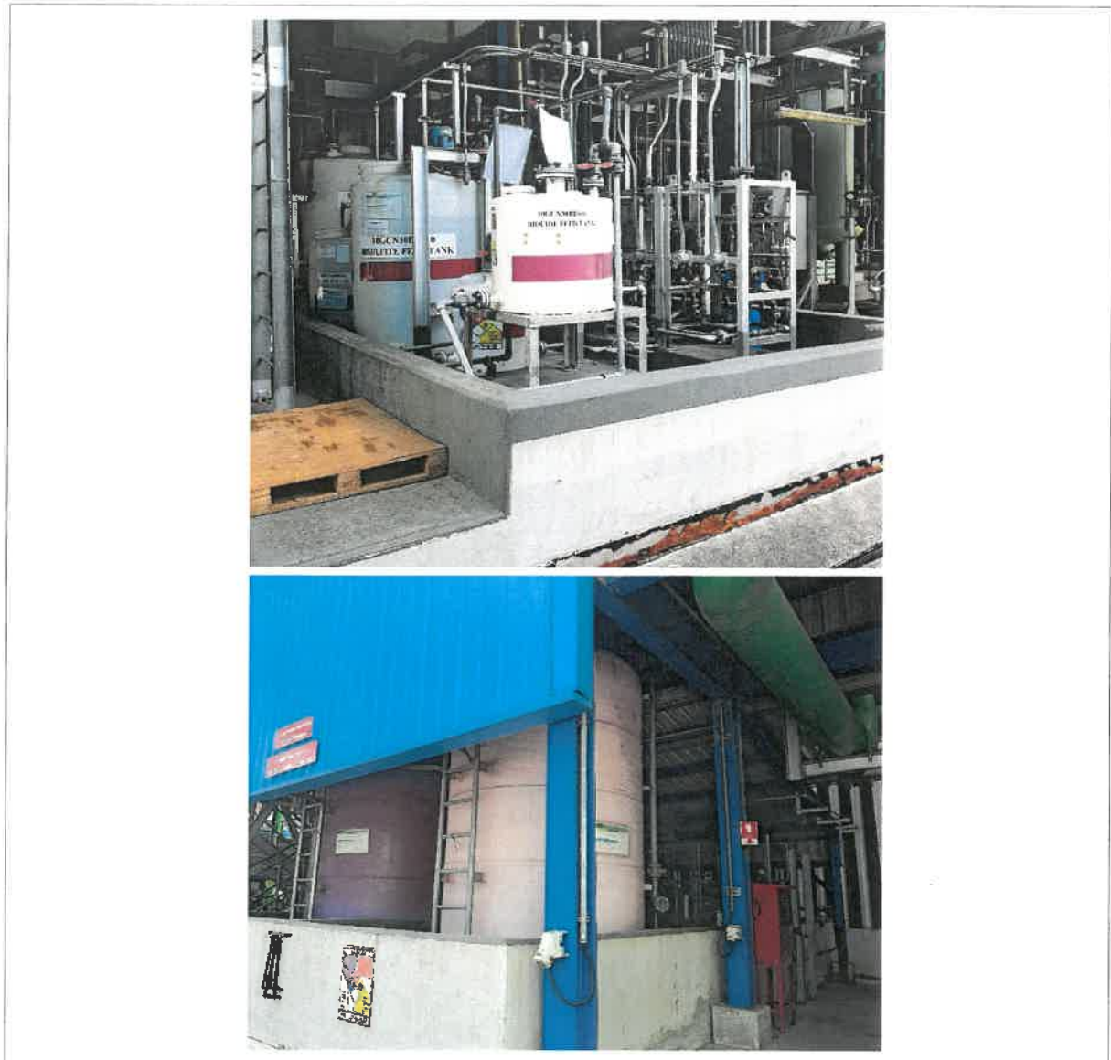
รูปที่ 2.6-1 ตัวอย่างการจัดเก็บสารเคมีบริเวณพื้นที่ใช้งานที่จำเป็นต้องใช้งานในกระบวนการผลิตอย่างต่อเนื่อง
